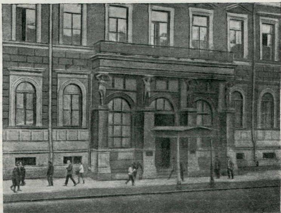
ДОМ НА ЛИТЕЙНОМ ПРОСПЕКТЕ ПРОТИВ КВАРТИРЫ НЕКРАСОВА
